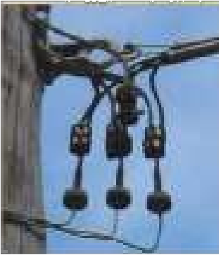
Монтажа на металоксиден одводник на пренапони 1 kV на надземен вод со изолирани проводници
