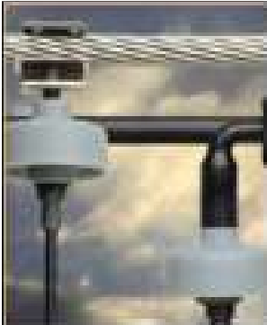
Монтажа на металоксиден одводник на пренапони 1 kV на надземен вод со голи проводници
