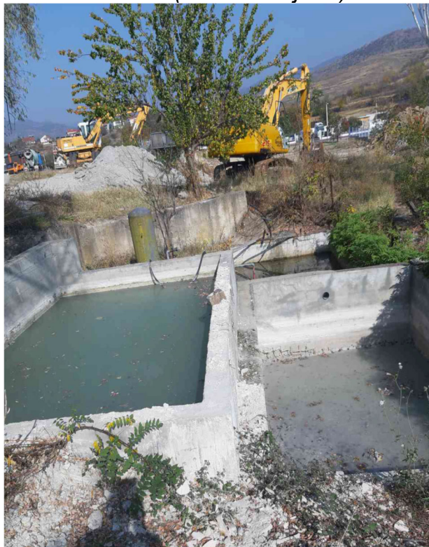
Трикоморен таложник за отпадни води од процесот
