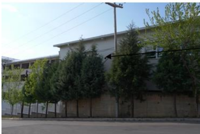
Вентилационен канали од производниот погон во хала III
