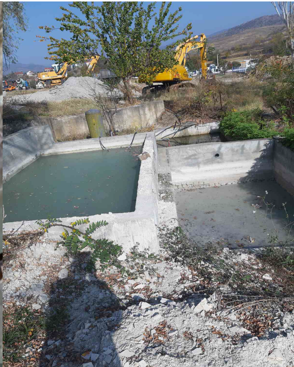
Трикоморен таложник за отпадни води од процесот
