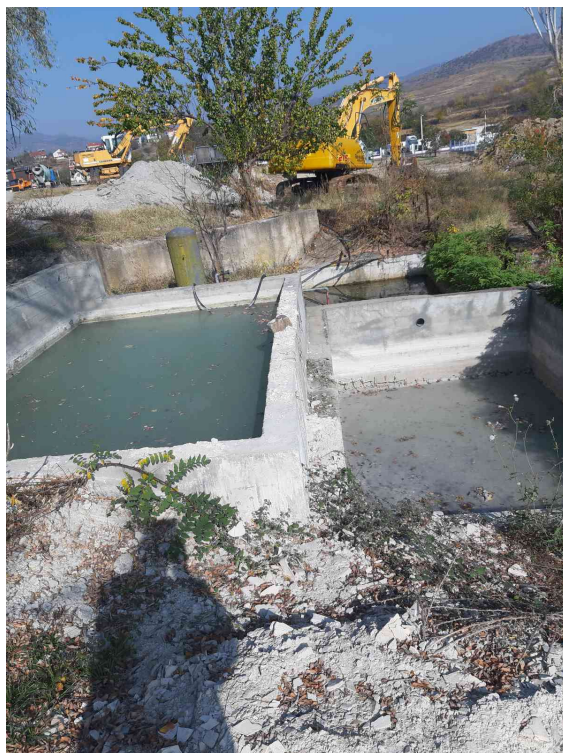
Сл. 4 - Трикоморен таложник за отпадни води од процесот
